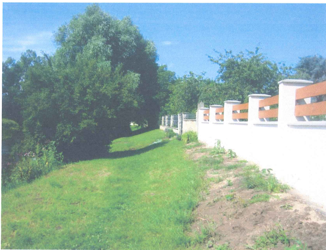
Oplocení nemovitostí ul. J.B.Foerstera od Jizery – podezdívky mají otvory a branky - nechrání před zaplavením
